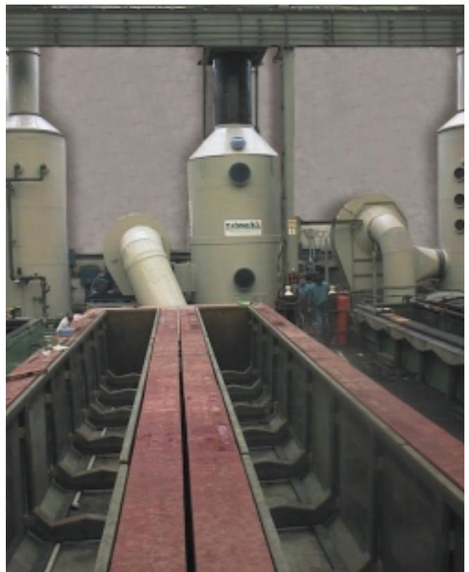
KVK-Abluftreinigungsanlagen kommen nicht nur bei gekapselten Vorbehandlungsanlage zum Einsatz, sondern auch bei Randabsaugungen. KÖRNER betreibt Anlagen verschiedener Bauart für HCl, H<sub>2</sub>SO<sub>4</sub>, HF und HNO<sub>3</sub>, bzw. Mischsäuren.
