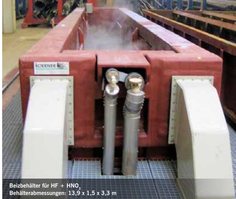
Gekapselte Beizanlage für Rohre Behälterabmessungen: 11,0 x 1,2 x 1,65 m
